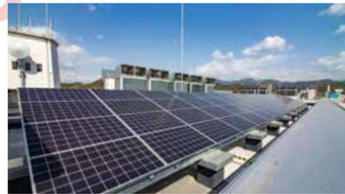
屋上に最大 30kw の発電が可能な太陽光発電設備を新たに設置し、自然エネルギーを生かしたエコな庁舎としました。
