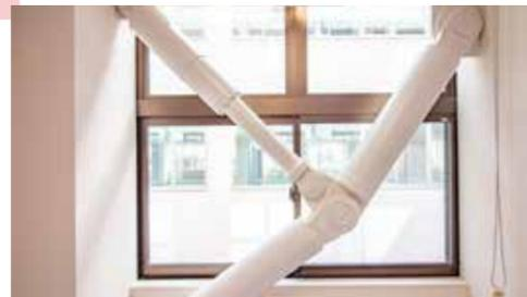
既存棟は地震時の揺れを吸収し、揺れを抑える「制震工法」を採用し、繰り返しの余震にも強い建物に生まれ変わりました。万一、電気が途絶えても非常用発電設備による電力供給が行え、災害時には、市民の皆さんの生命と財産を守る司令塔として重要な役割を担います。
