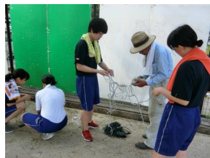
【稲枝ルミネ看板の電気配線作業】
