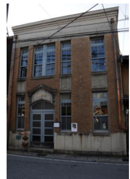
高崎家住宅主屋（旧川原町郵便局舎）
