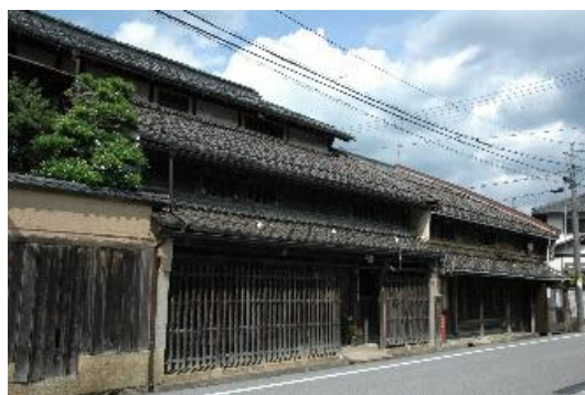
村岸家住宅（江戸時代建築）
