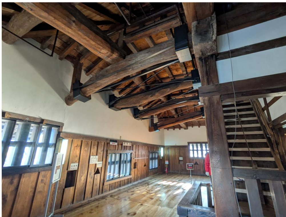
彦根城天守の耐震工事(写真は1階部分) (令和7年1月)
