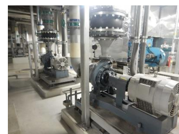
5E-60ボイラー
