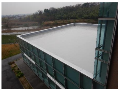
5E-33療法屋上防水工事後
