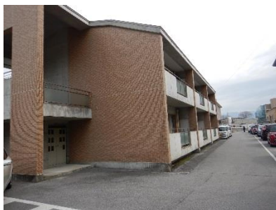
1 外壁・バルコニー
