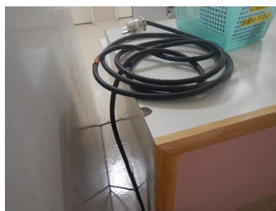
7F-1 造作家具破損
