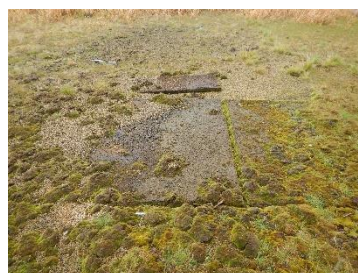
5E-20表土がない状態
