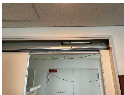
点検口を開けた状態 ダンパーと扉の固定金具(右下部分)
