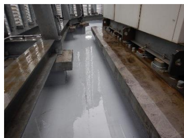
5E-26防水改修後
