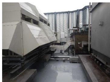
5E-25防水改修後
