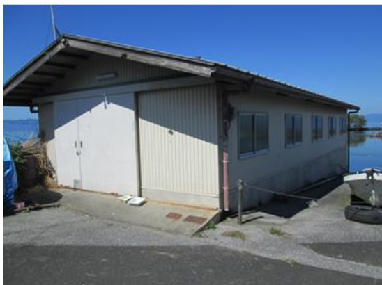
②-1 外観（正面・東側から）
