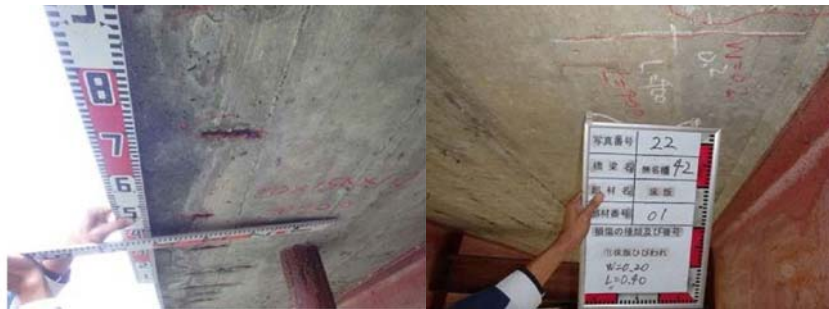
図 - 無名橋 42 の損傷図と損傷写真
