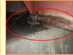
コンクリート部分の損傷
