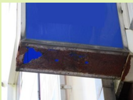
底部の腐食
