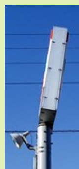
上部構造物の傾斜
