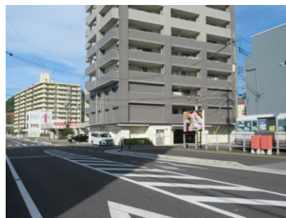
駅西周辺地区
