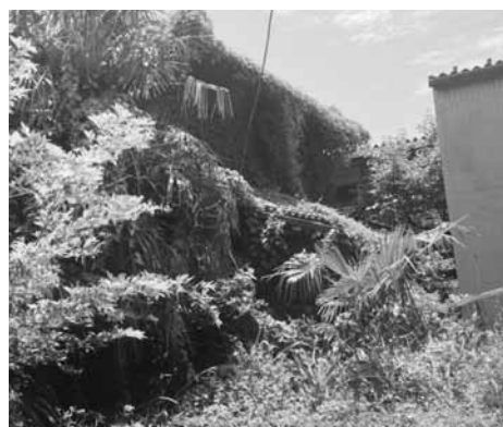
▲草が繁茂している空き家
