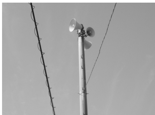
▲地域の重要な情報伝達手段・屋外放送設備の一例
