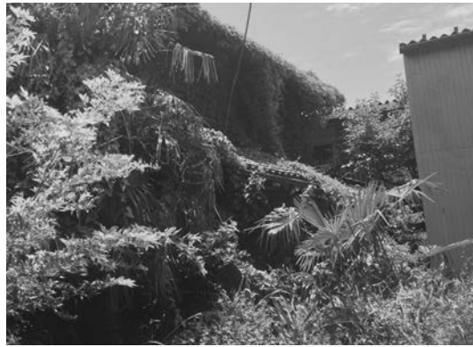
▲草木に埋もれている空き家
