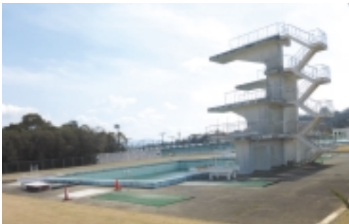
▲解体予定の現スイミングセンター
