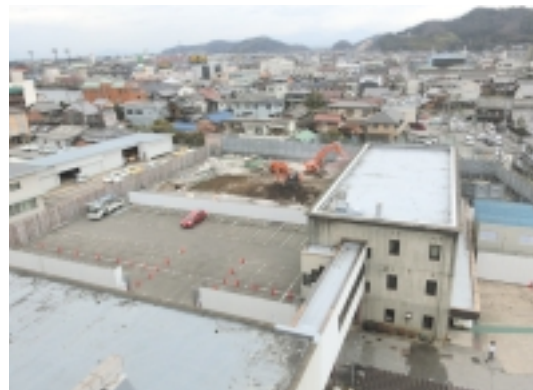
▲立体駐車場の建設に向け、解体工事が進む市庁舎北側の敷地
