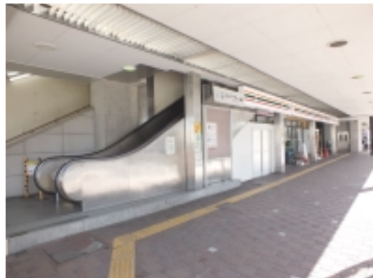
▲彦根駅西口エスカレーター
