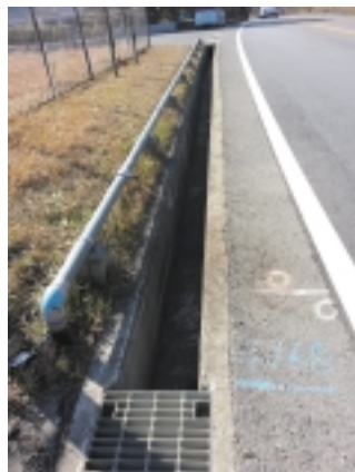
▶道路脇に設置された融雪装置 (市外での例)
