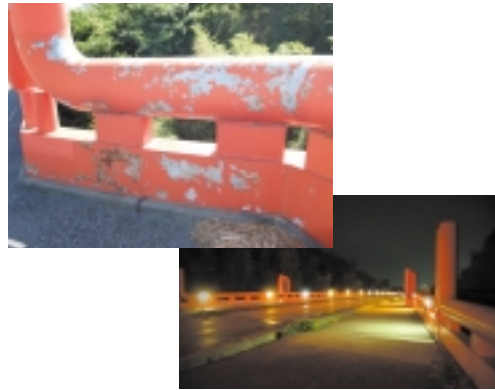
▲開出今橋（通称赤橋）
