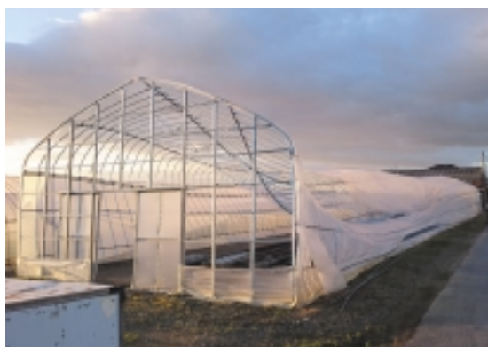
▲ビニールが破損しパイプが曲がったビニールハウス
