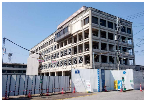
▲市庁舎耐震化工事中の様子
