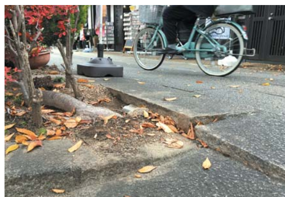
▲ケヤキの根上りにより段差ができた歩道
