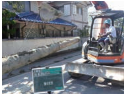
▲老朽水道管更新工事
