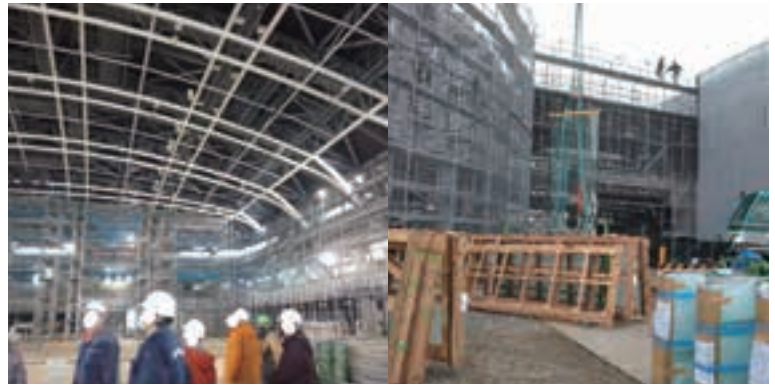
▲建設中のスポーツ・文化交流センター
