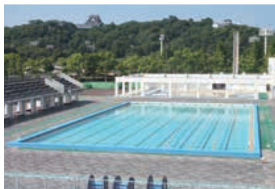
▲解体前の滋賀県立スイミングセンター
