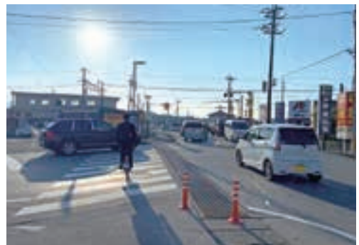
▲国土交通省が危険な踏切道として指定した「神宮」踏切
