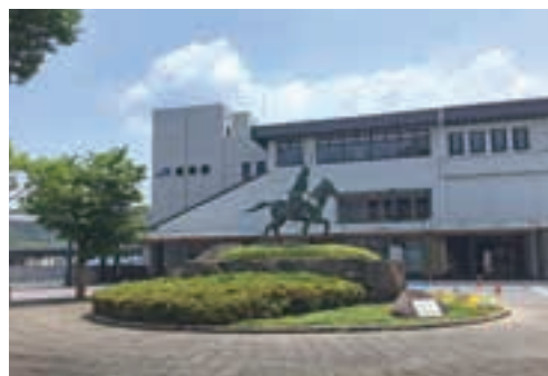
▲再整備計画が進んでいる彦根駅西口一帯
