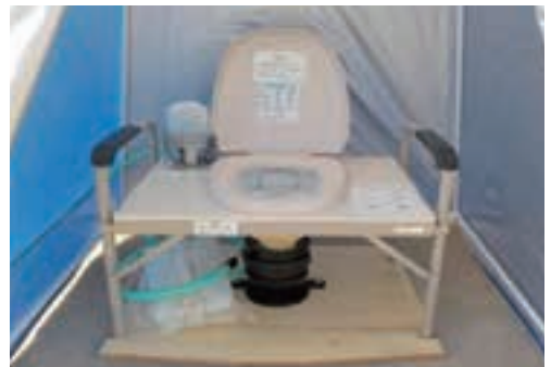
▲マンホールトイレのテント内部
