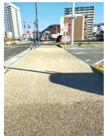
▲水たまりができない構造の歩道の舗装
