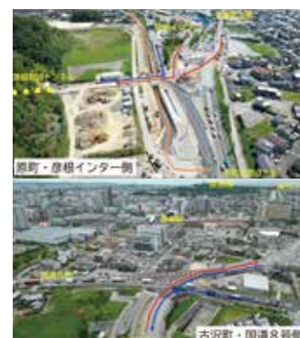
▲彦根お城トンネル開通後の「原町・彦根インター側」、「古沢町・国道8号側」それぞれの車の誘導
