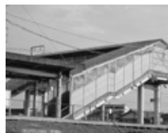
▲稲枝駅跨線橋
