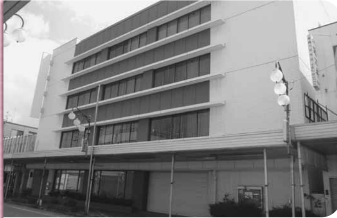
▲仮庁舎（GS彦根キャッスルビル）
