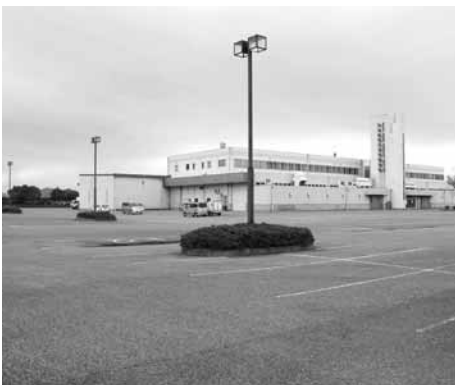
▲卸売市場東側の給食センター建設予定地
