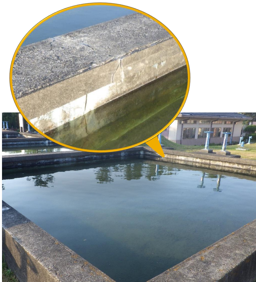
(大藪浄水場 緩速ろ過池)
