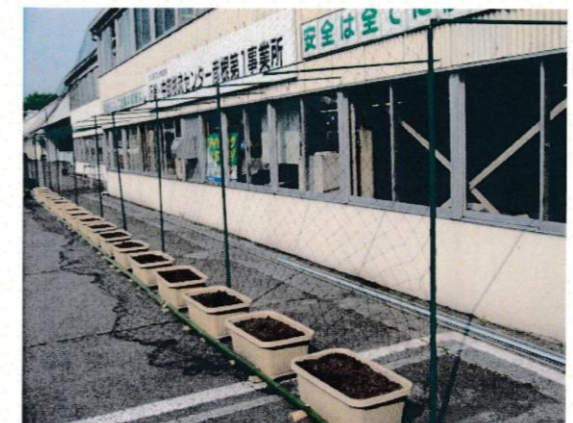
グリーンネットの枠組み・土の準備
