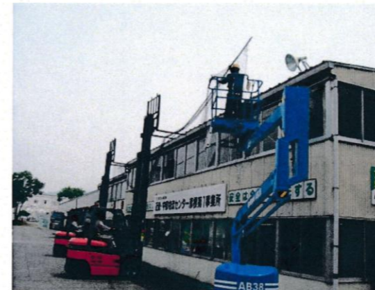
ネット貼り作業
