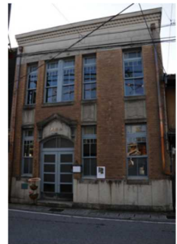
高崎家住宅主屋（旧川原町郵便局舎）
