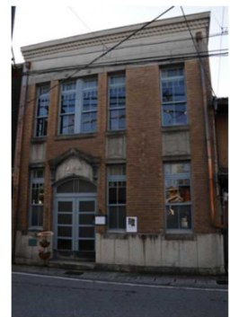
高崎家住宅主屋（旧川原町郵便局舎）
