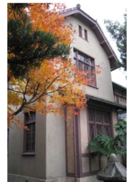
若林家住宅洋室棟
