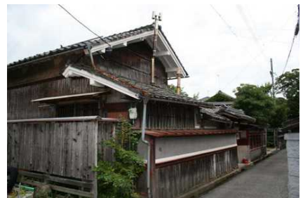
旧彦根藩足輕組屋敷（善利組・中居家住宅）
