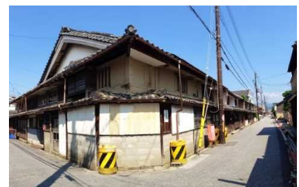
保存修理が必要な歴史的建造物
