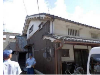
消防点検と文化財パトロール
