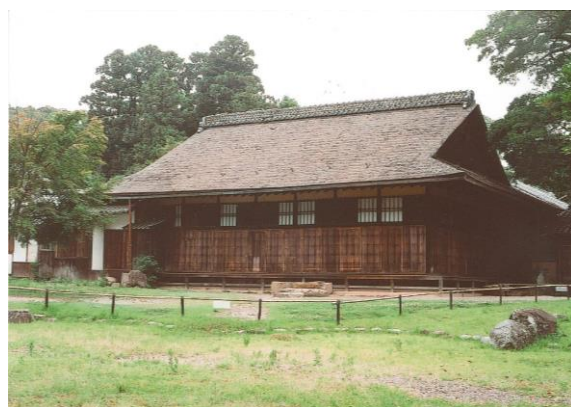
写真 1 御書院棟外観（東面）
