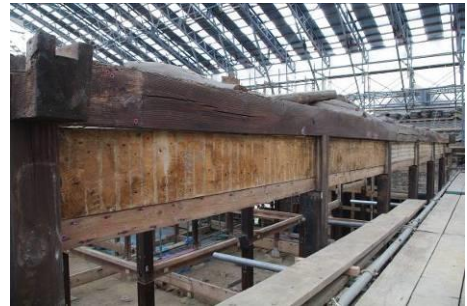
写真 7 小壁下地板
