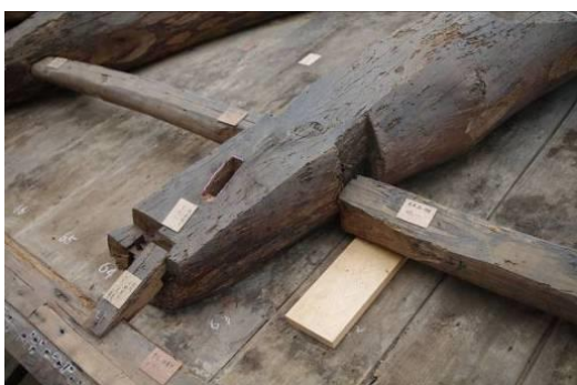
写真10 桔木先端に残る短い野垂木
