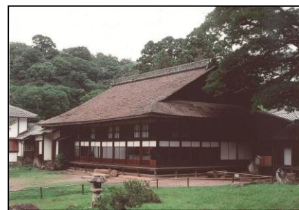
修理前の御書院
