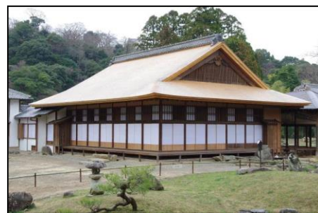
修理後の御書院
