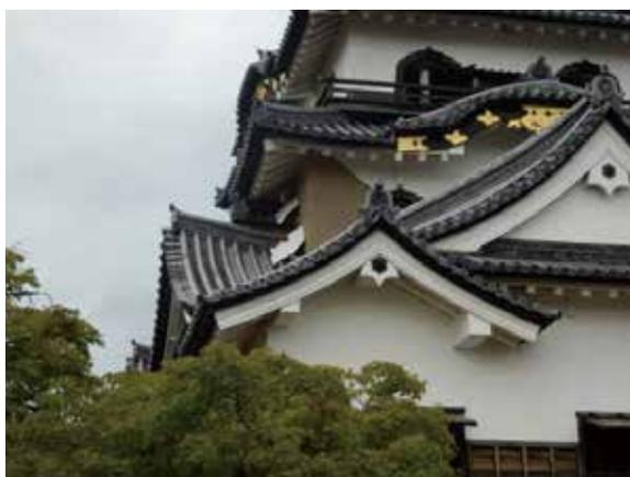
図 4.4.3 天守二層 東面外壁 漆喰剥落状況
