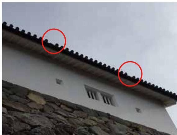
図 4.4.6 西の丸続櫓南面 屋根巴瓦落下状況
