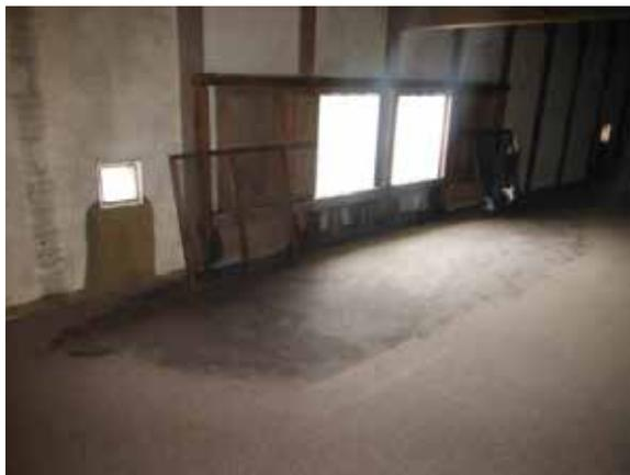
図 4.4.1 西の丸三重櫓一層西側 雨漏状況
