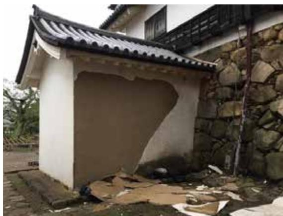
図 4.4.4 玄関 西面外壁 漆喰剥落状況
