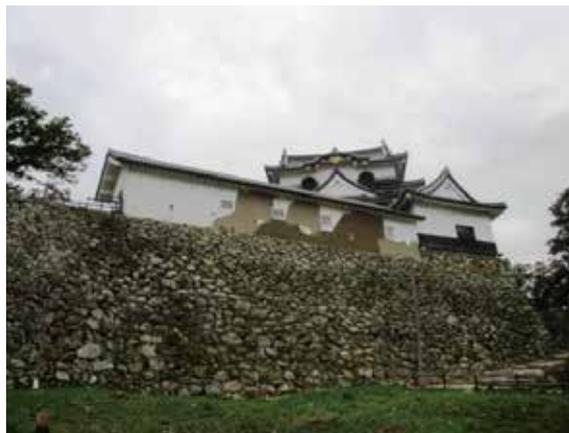
図 4.4.2 多間櫓 東面外壁 漆喰剥落状況
