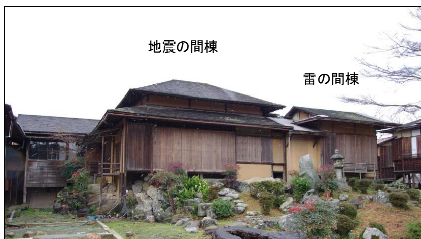
修理前の地震の間
