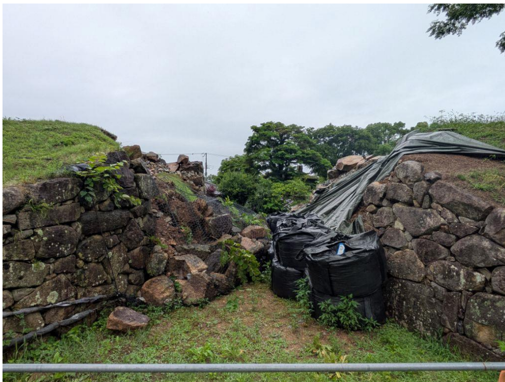
米蔵水門石垣 山側から
