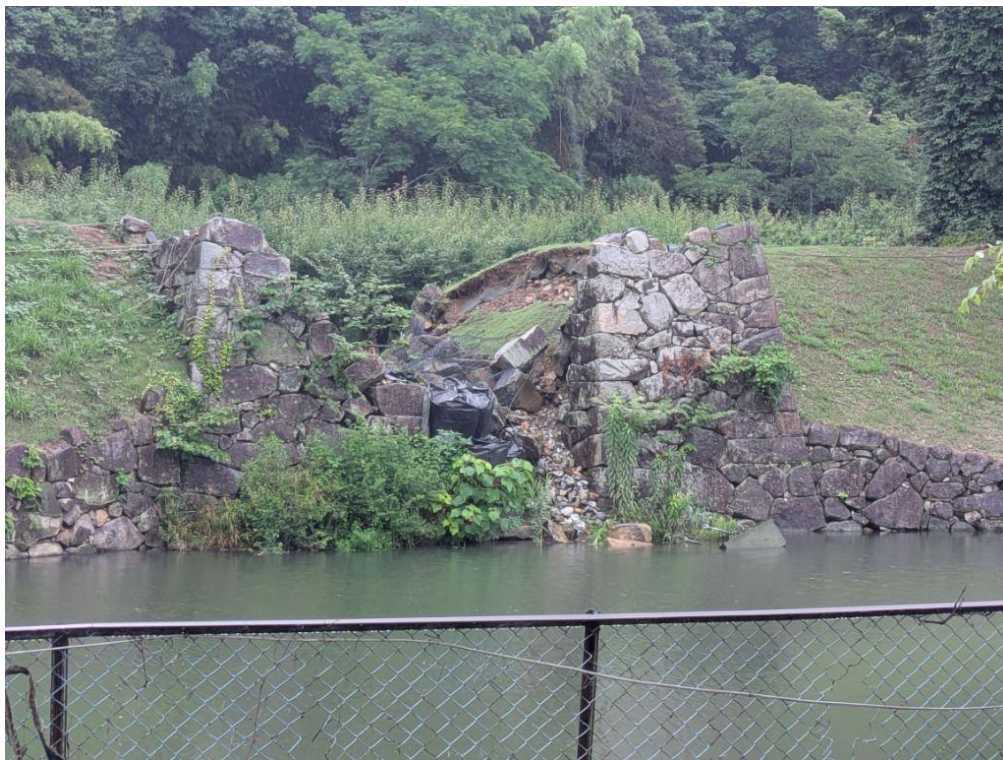
米蔵水門石垣 対岸から
