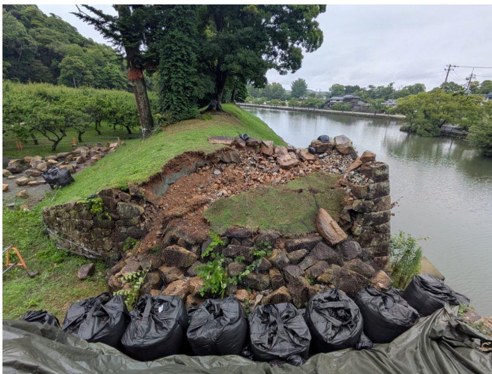
米蔵水門石垣 上側から
