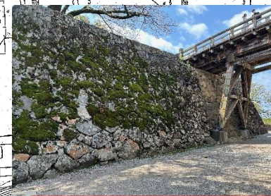
作業場所 (大堀切石垣)
