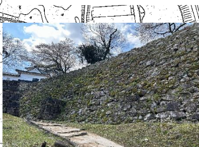
作業場所 (西の丸北側石垣)
