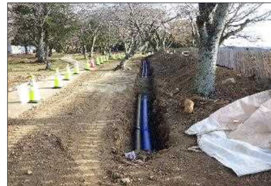
金亀町(彦根城西の丸) 令和8年1月21日(水)撮影
