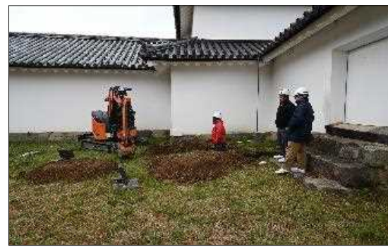
金亀町(彦根城西の丸) 令和7年12月3日(水)撮影
