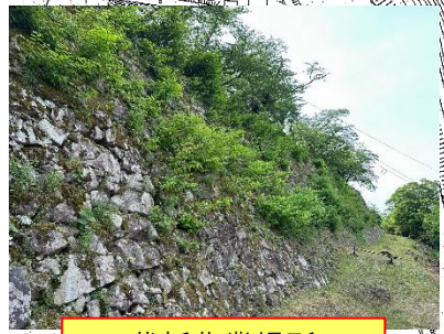
伐採作業場所 (西の丸北側石垣)
