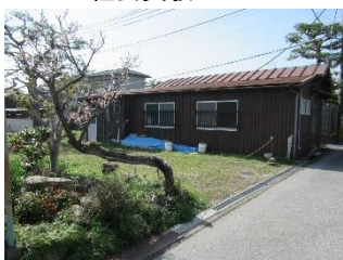
芹橋二丁目防災広場予定地 R3.3
