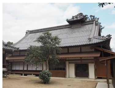
荒神山神社「社務所の保存修理」 社務所「外観」 R2.1
