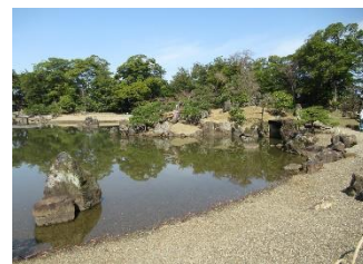
魚躍沼護岸の保存整備 R4.3
