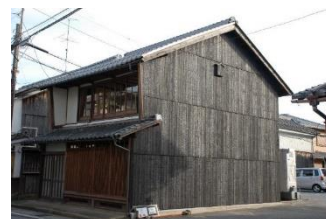
伝統的建造物の修理 H31.1
