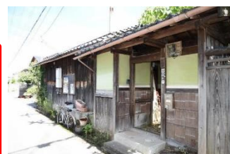
未指定文化財建造物の調査 R元.10
