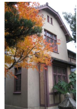
若林家住宅洋室棟
