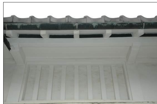
⑤ 虫籠窓と軒裏の塗り込め
