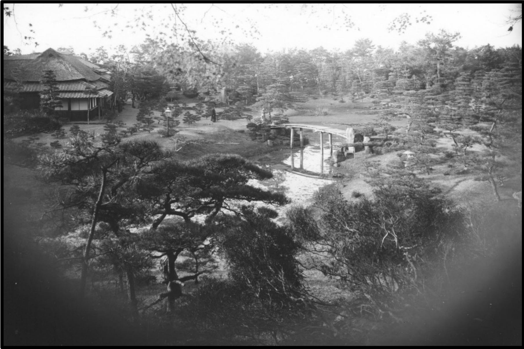
古写真（住時の庭園、東より見る）
