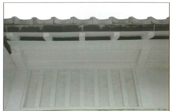
⑤ 虫籠窓と軒裏の塗り込め
