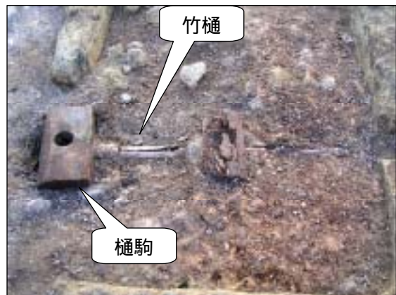
写真10 上水遺構（竹樋と樋駒）
