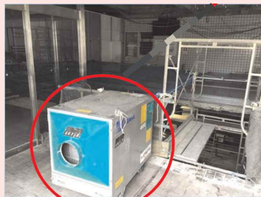
集塵機を設置し室内の換気を実施
