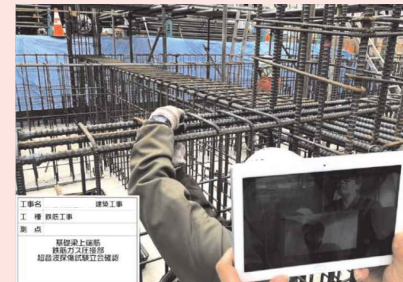
Webカメラを利用した遠隔検査
