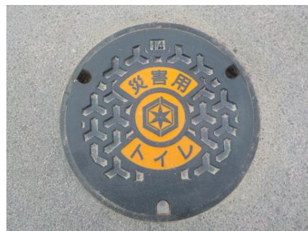
【専用マンホール】
